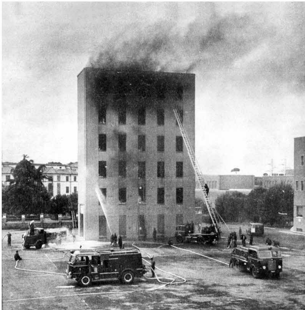
SCUOLE CENTRALI ANTINCENDI - CAPANNELLE (ROMA) - NOVEMBRE 1955 - FEBBRAIO 1956
