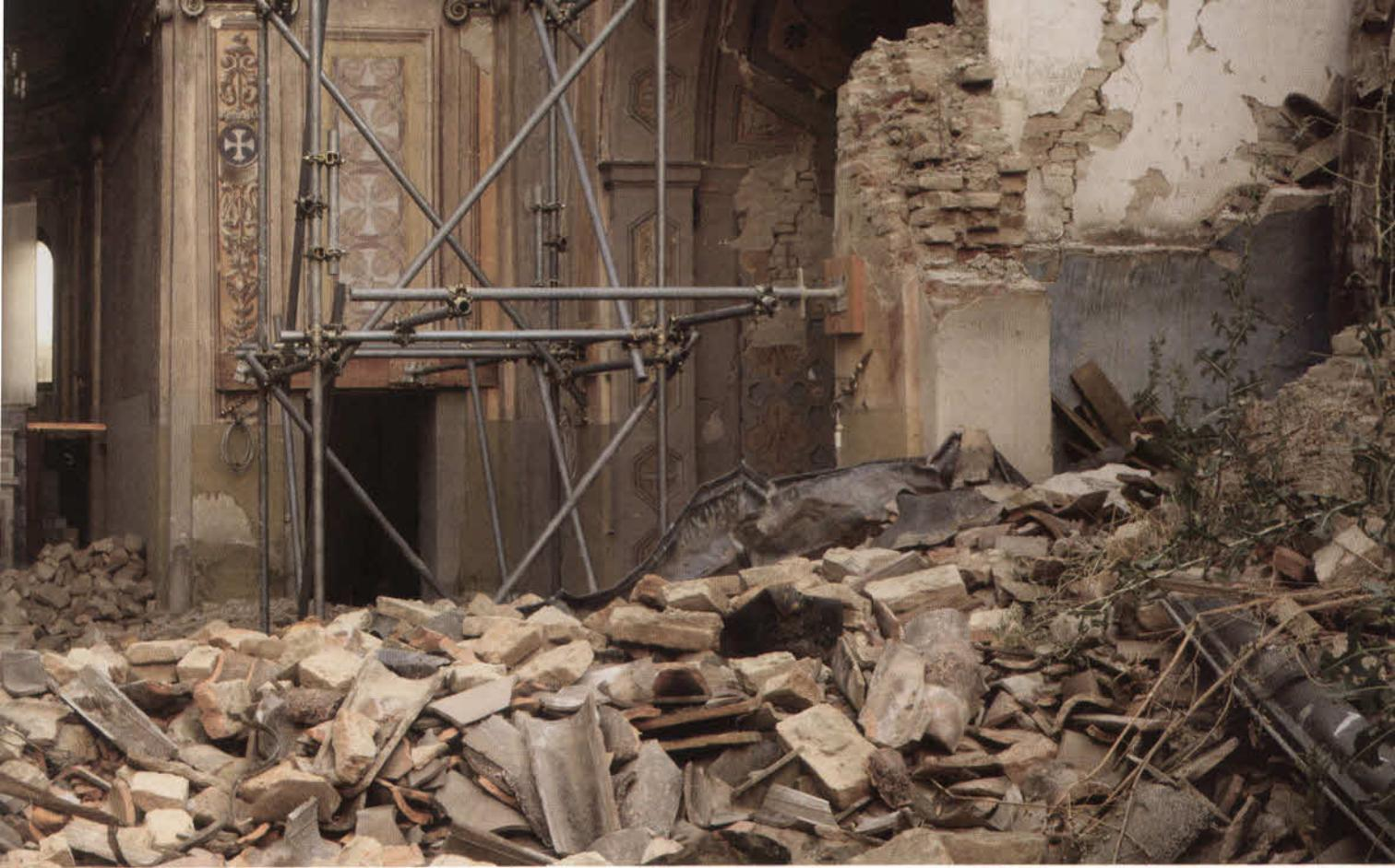
L'intervento prevedeva la messa in sicurezza delle strutture superstiti, il recupero di materiali da costruzione originali, e la realizzazione di una copertura provvisoria, essendo crollato totalmente il tetto.
