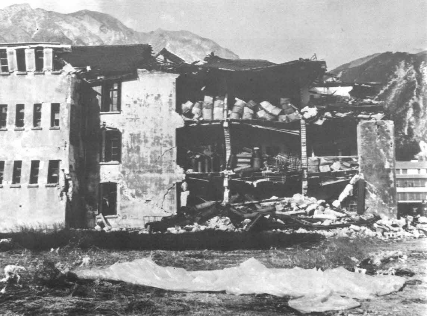
fig. 1C) - Vista frontale del deposito del cotonificio: tetto e parete frontale parzialmente crollati.
