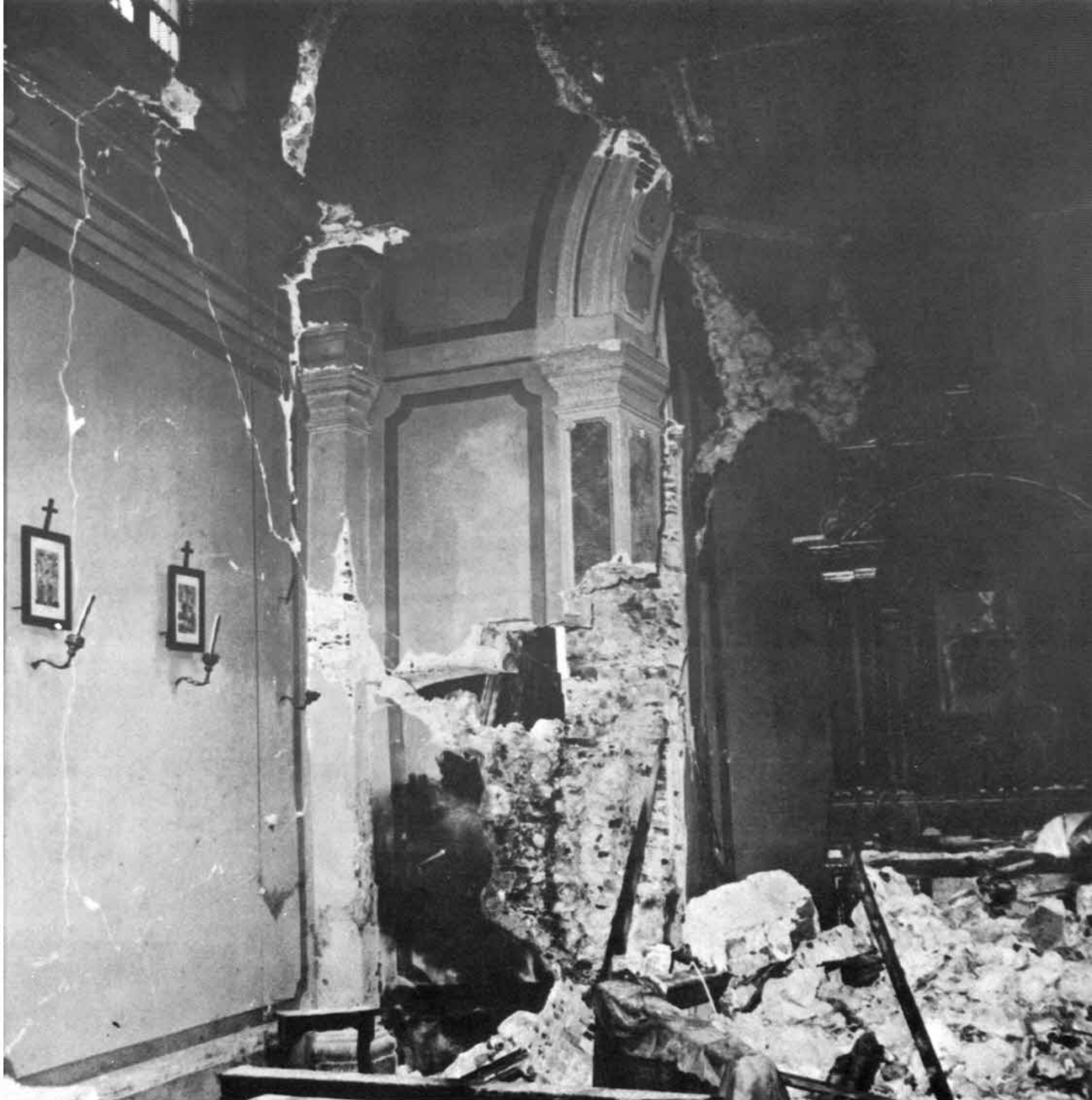
fig. 10D) - Veduta dell'interno della stessa chiesa.
