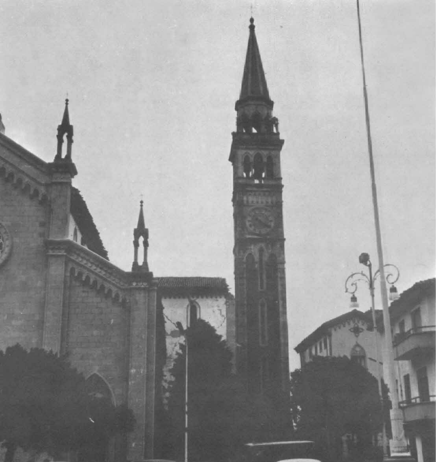
fig. 3F) - Campanile del Duomo: la struttura apparentemente in muratura è in realtà in c.a.-
