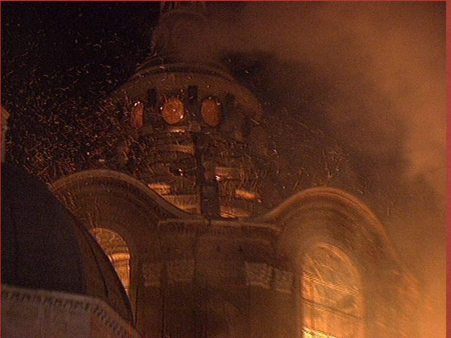
La Cappella diventata ormai un enorme camino
