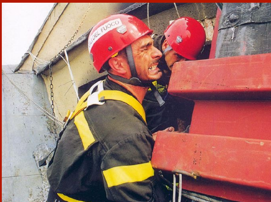
Alcune fasi della messa in sicurezza dell'edificio, con la cerchiatura della cupola con cavi in acciaio e il posizionamento delle selle di contenimento delle nervature della cupola.
