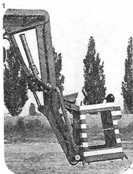
Foto n. 1 - Braccio corto con cestello e monitori acqua schiuma in posizione di riposo.
