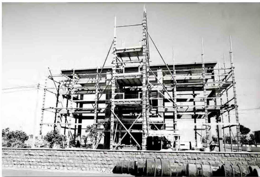
Fig. 29 - Lavori di ampliamento del complesso delle Scuole
