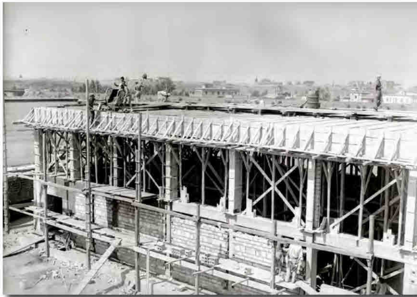
Fig. 28 - Lavori di ampliamento del complesso delle Scuole
