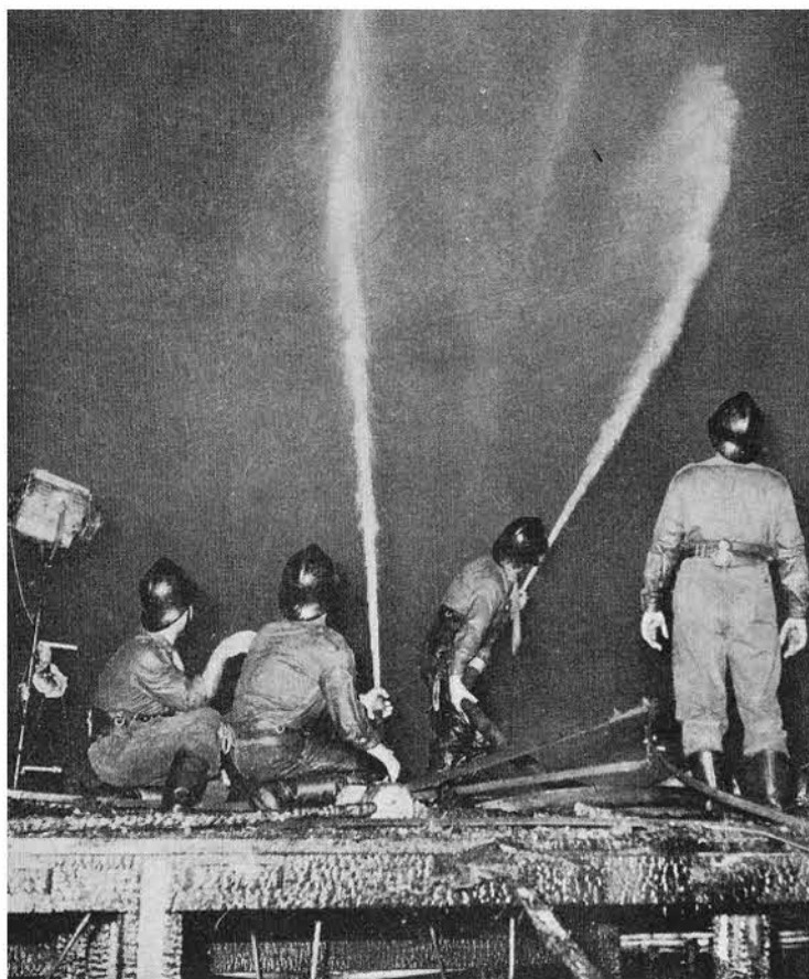
Incendio di locale pubblico
