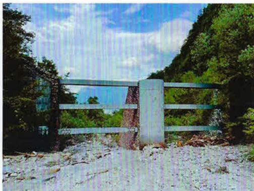
A fianco: 11 agosto 2011 - Briglia filtrante realizzata lungo il Rio Gola
