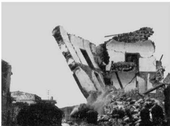
Poggioreale. - Demolizione della facciata pericolante dell'Ospedale civile (operazione diretta dall'ing. Scirè mediante una pala meccanica ed interposto trave in legno recuperato dalle macerie)
