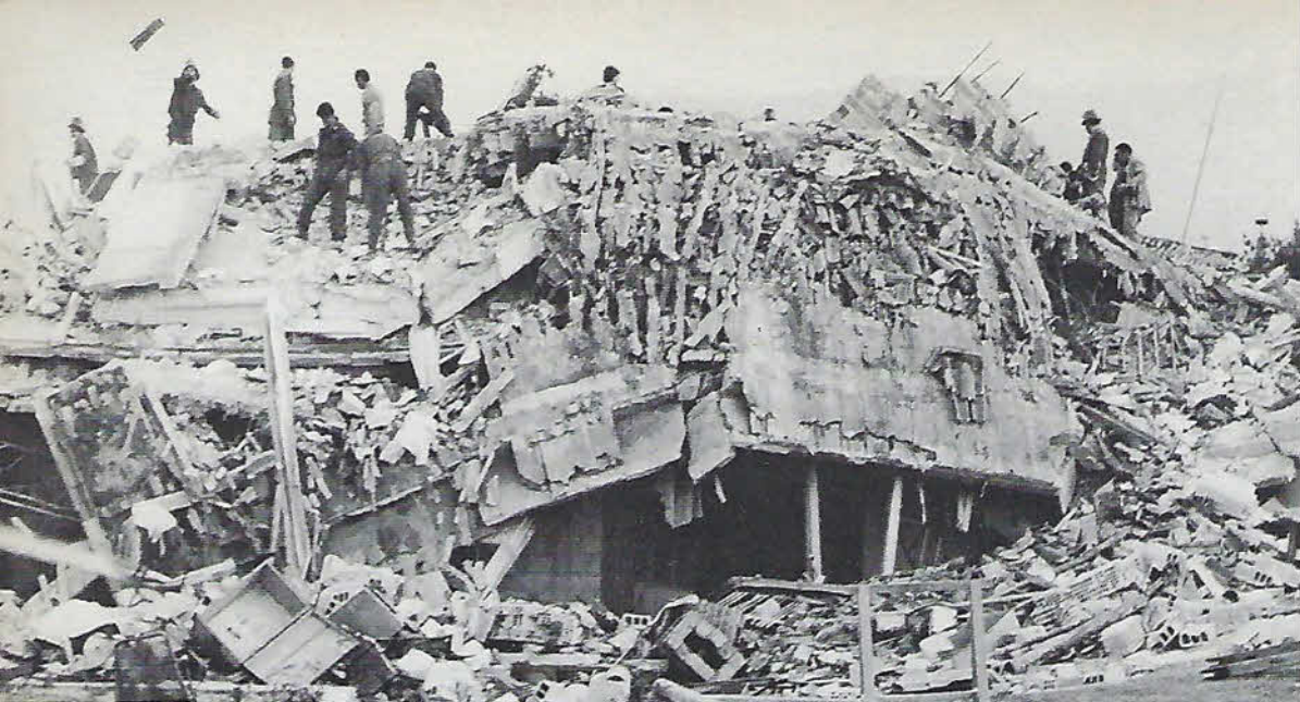
MAJANO - L'allucinante spettacolo del ristorante «Da Gardo»: sotto quasi 30 morti. Il proprietario si è miracolosamente salvato.
