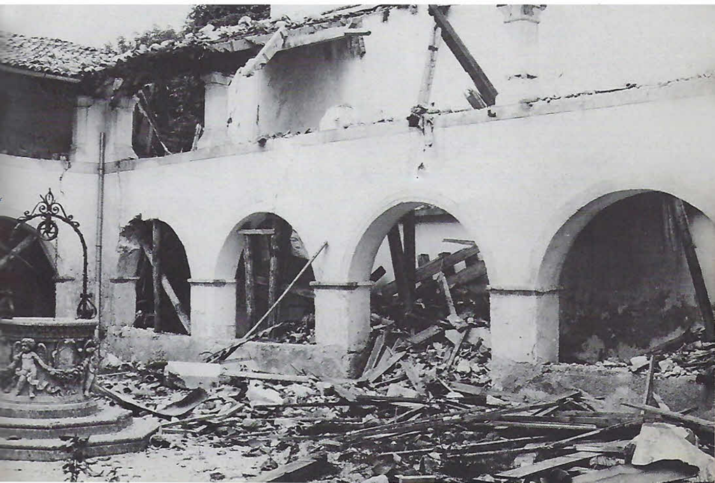
MOGGIO - L'Abbazia di Moggio Alto. La terra ha tremato sconvolgendo la purezza delle sue linee architettoniche.
