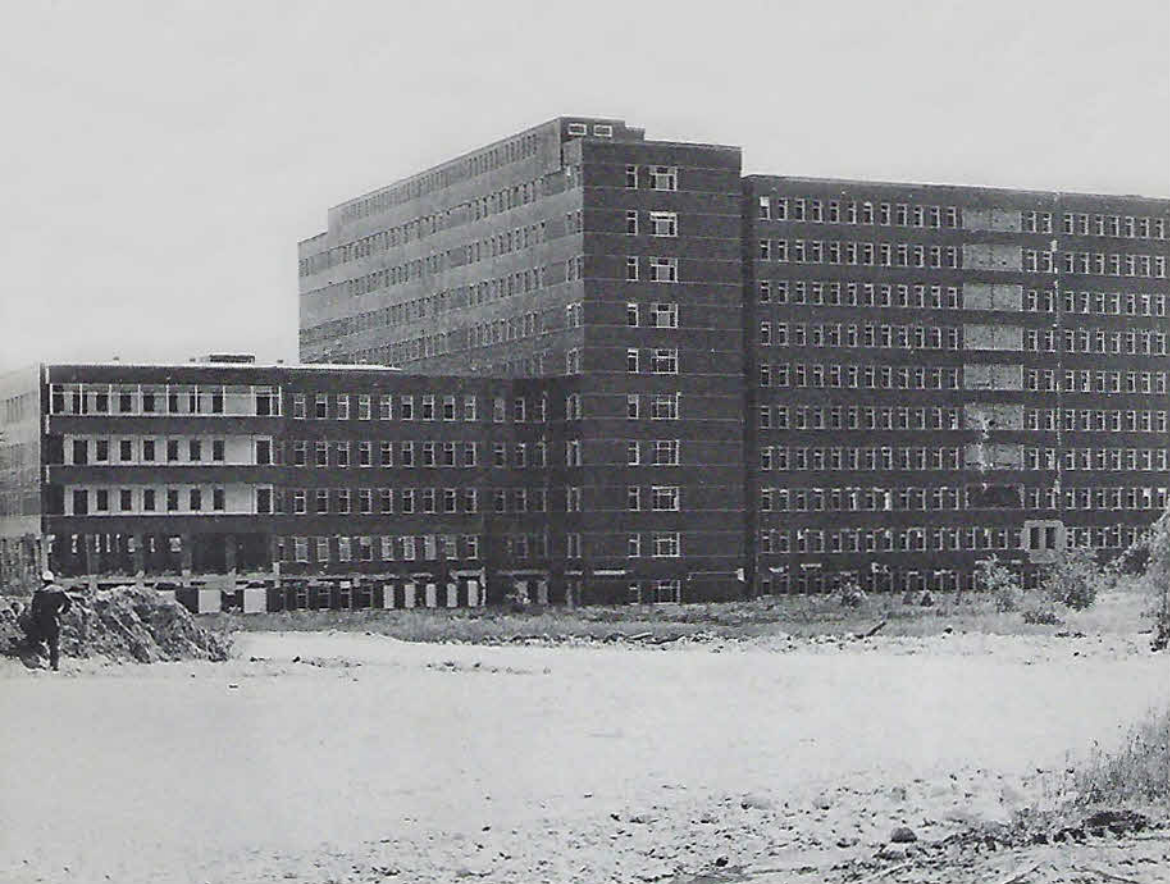
GEMONA - L'ospedale nuovo di Gemona. Un gioiello di dimensioni comprensoriali com'era subito dopo il terremoto. L'ala nord, quella a sinistra nella foto, era gravemente danneggiata e minacciava di far crollare anche la parte rimanente. Si decide di abbatterla con il tritolo.
