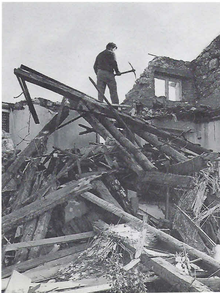
MOGGIO - Demolire per ricostruire.
