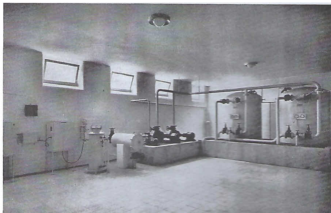
L'impianto di coagulazione, filtrazione e sterilizzazione dell'acqua della piscina
