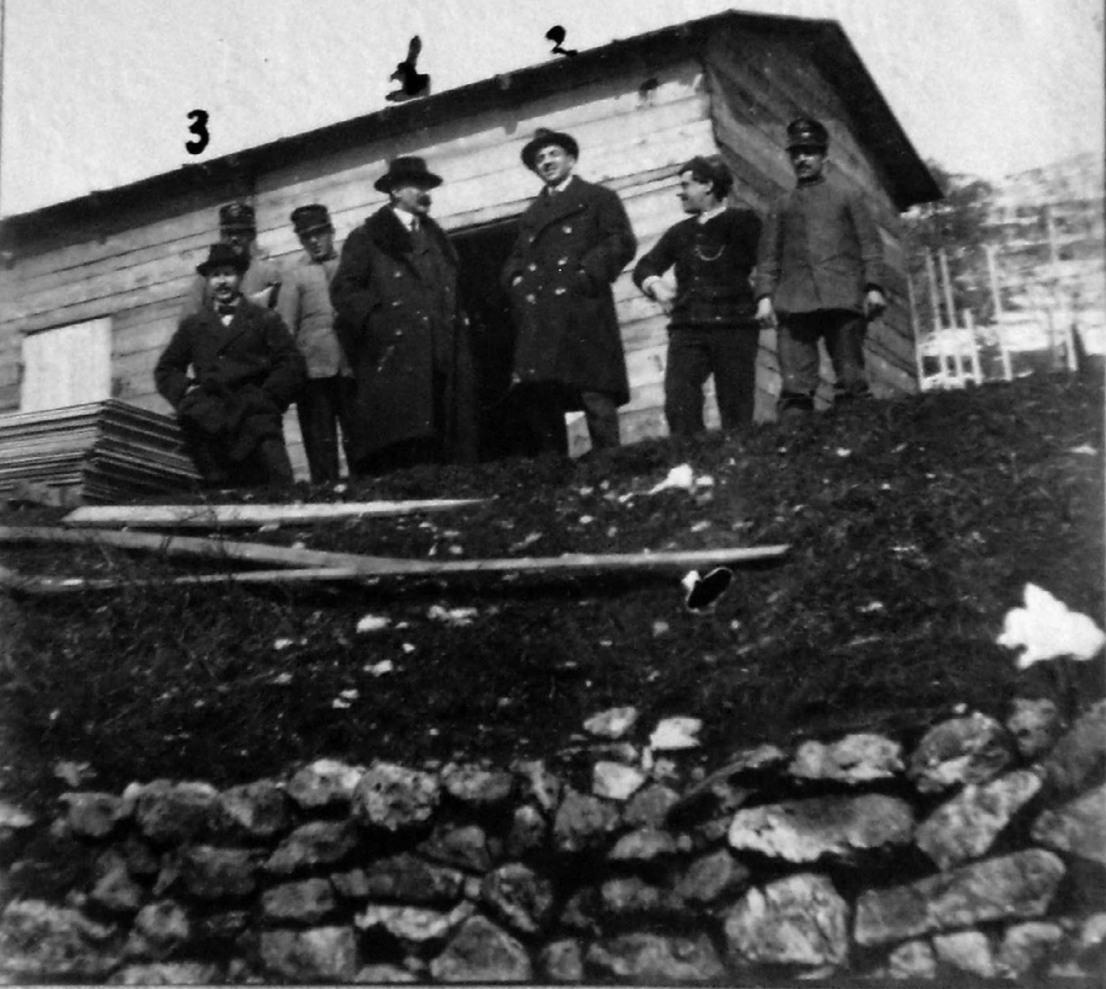
L'On. Agnini (1) - il Sindaco di Finale (2) - il Sindaco di Mirandola (3) in visita dei lavori
