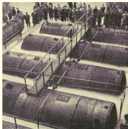
Fig. 2 — Riempimento di una fossa di serbatoi con anidride carbonica
